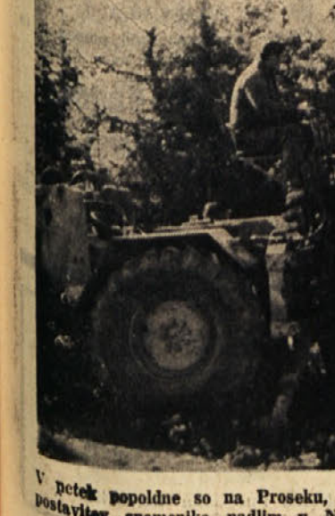
V petek popoldne so na Proseku, pri odcepu seste proli gostišča Martin, začeli pripravljati zemljišče za postavitev spomenika padlim v NOB. Gradnja spomenika že dalj časa napoveduje dvojezični napis na tabli
