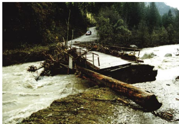
Slika 6: V poplavi novembra 2000 je narasla Savinja močno poškodovala cestni most v Robanov kot (foto: Arhiv ARSO).
