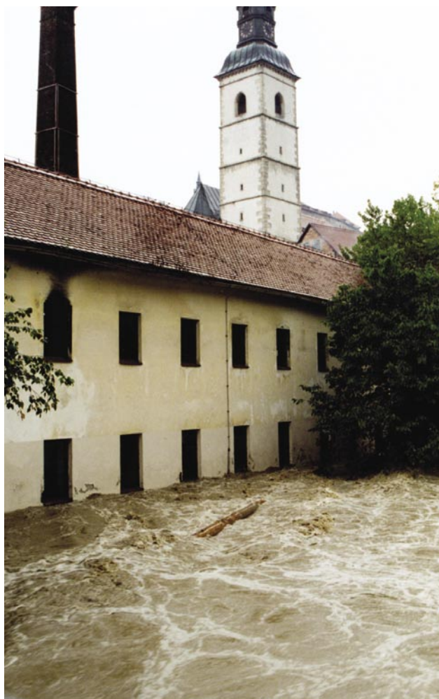
Slika 3: Narasla Selška Sora oktobra 1998 v Škofji Loki (foto: Arhiv ARSO).
