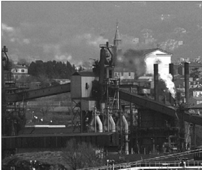
Pogled na škedenjsko železarno
