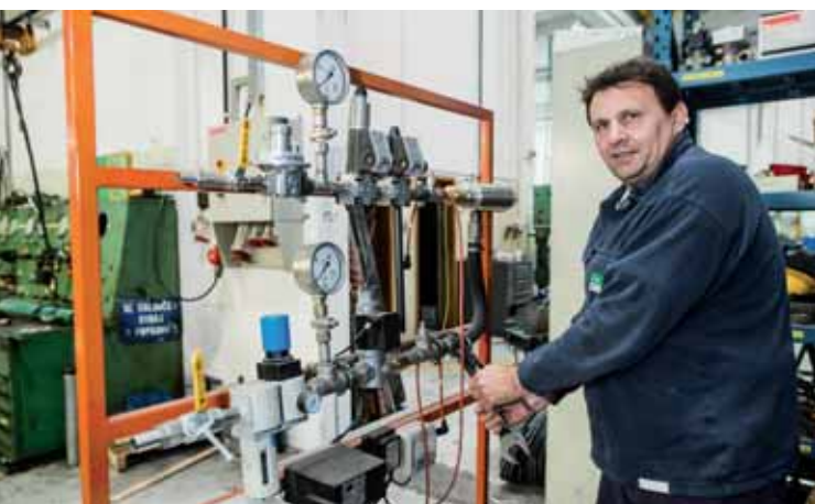
Nova plinska rampa
