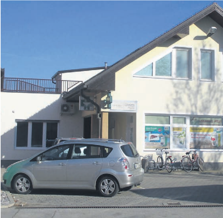
Na občini Videm so za izgradnjo prizidka in rekonstrukcijo zdravstvenega kleti prizidka bodo obrtniški prostori, v pritličju zobozdravstvena ordinacija,
