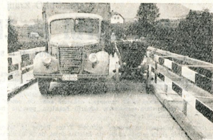
Srečanje dveh vozil, ki sta običajni na suškem mostu. Pogost pojav, ki zgovorno priča, da nekateri vozniki še vedno premalo upoštevajo prometne znake. Nesreče so zato neizbežne. Tudi ta slika nam to priča; vsa sreča, da ni bilo pri srečanju poškodb
