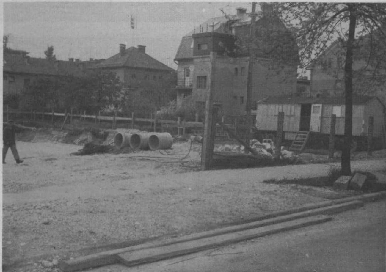
Dolgoletne želje bežigraskih mladičkov se bodo kmalu uresničile. Iz starih, popolnoma neustreznih prostorov, se bodo konec letošnjega ali v začetku prihodnjega leta preselili v novo stavbo, ki so jo začeli graditi v Posavskega ulici. V pritličju, treh nadstropjih in kleti bo 1909 metrov uporabne površine, kjer bodo prostori postaje mlilce, garaže in stanovanja za uslužbenke. Gradnja bo stala skoraj 27 milijonov dinarjev, denar pa bodo zagotovili občinska skupščina, republiški sekretariat za notranje zadeve in uprava javne varnosti.
