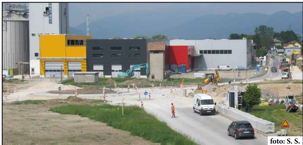
Dela južno ob železnici potekajo po načrtih.
