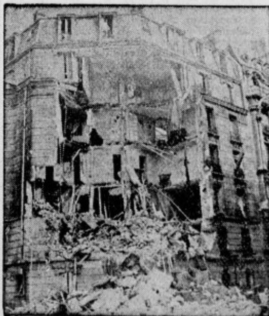
Porušena hiša v Parizu. Zadel jo je bomba z letala.
