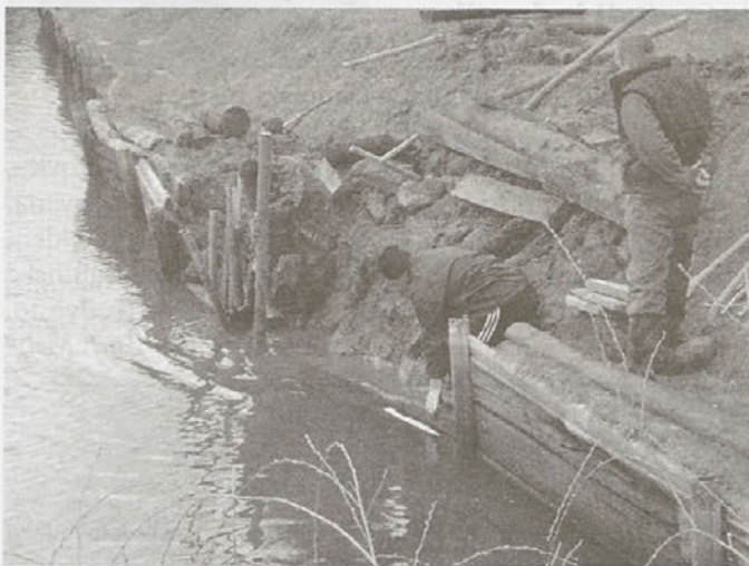
Najtežji in najzahtevnejši odsek urejanja brežine
