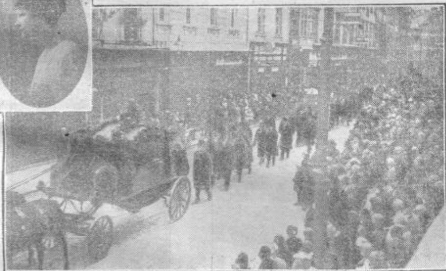
Pogreb Dane Koblerjeve
