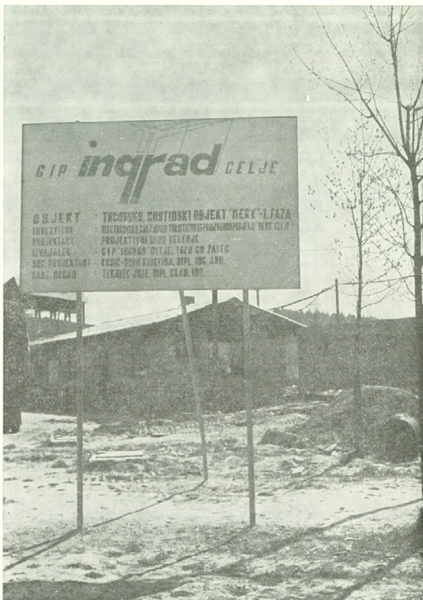
Príprava gradbišča v Bevcáh pri Velenju
