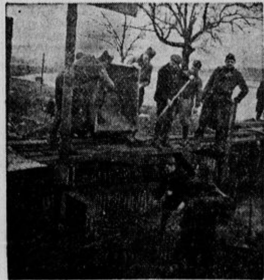
Francoski vojaki betonirajo novo postojanko.
