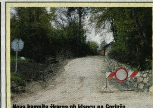
Nova kamnita škarpa ob klanecu na Gorjušo
