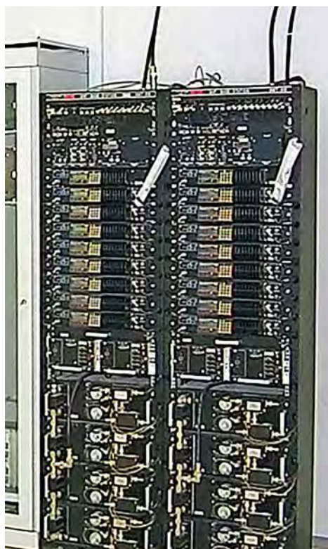
8-kanalna bazna postaja NMT na Kumu (foto: Tomaž Levičnik)
