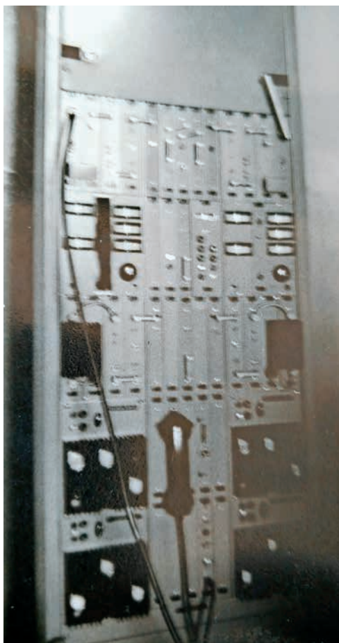
Analogni RR-sistem Face Standard, zmogljivost 300 telefonskih kanalov, konfiguracija 1+1 (foto: Darko Jelen)
