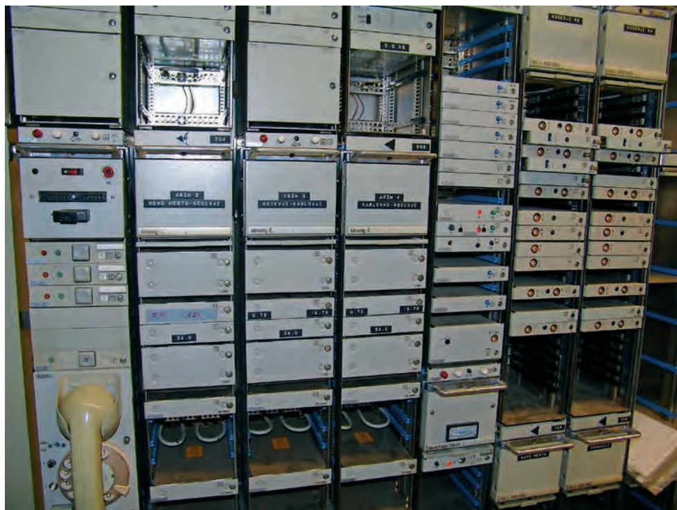
Linijski ojačevalniki v rezervnih centrih so ojačevali prenosne poti in s tem povečevali domet zvez. (foto: Jernej Bizjak)
