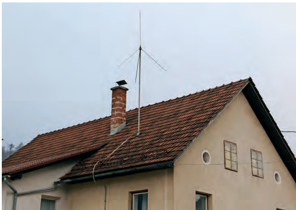
Vertikalna GP-antena na strehi krajevne skupnosti Borovnica (foto: Peter Žitko)
