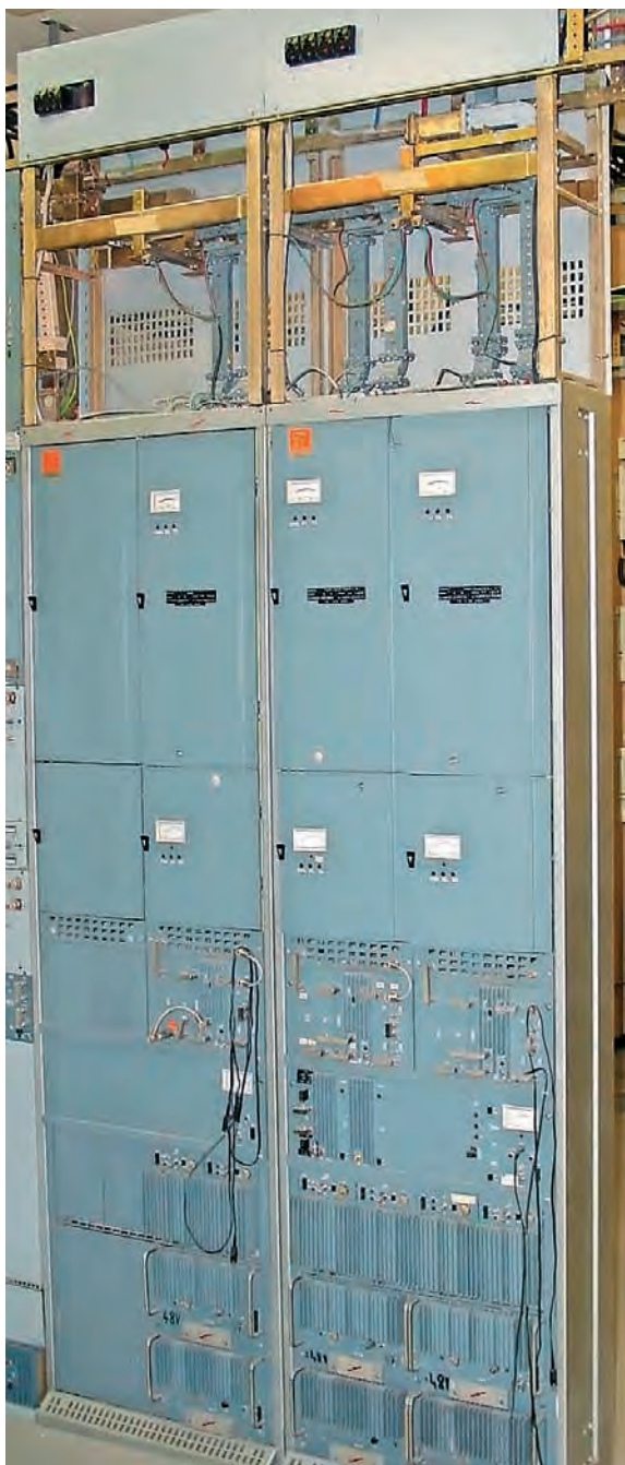
Analogni RR-sistem Telettra HT12-6L, zmogljivost 2 x 1800 tel. kanalov, Krim, smer Kum, konfiguracija 2+1 (foto: Darko Jelen)
