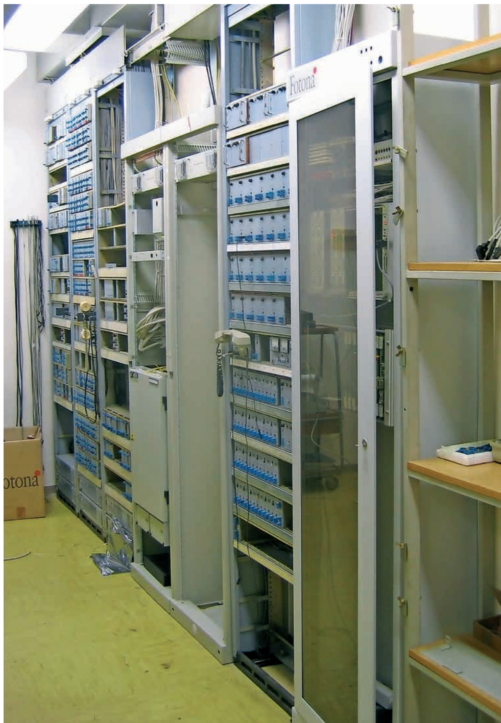
ISEP-tehnologija je bila najprej vodoravno zasnovana 12-kanalna analogna tehnika prenosa proizvajalca Iskra. (foto: Marjan Kleva)
