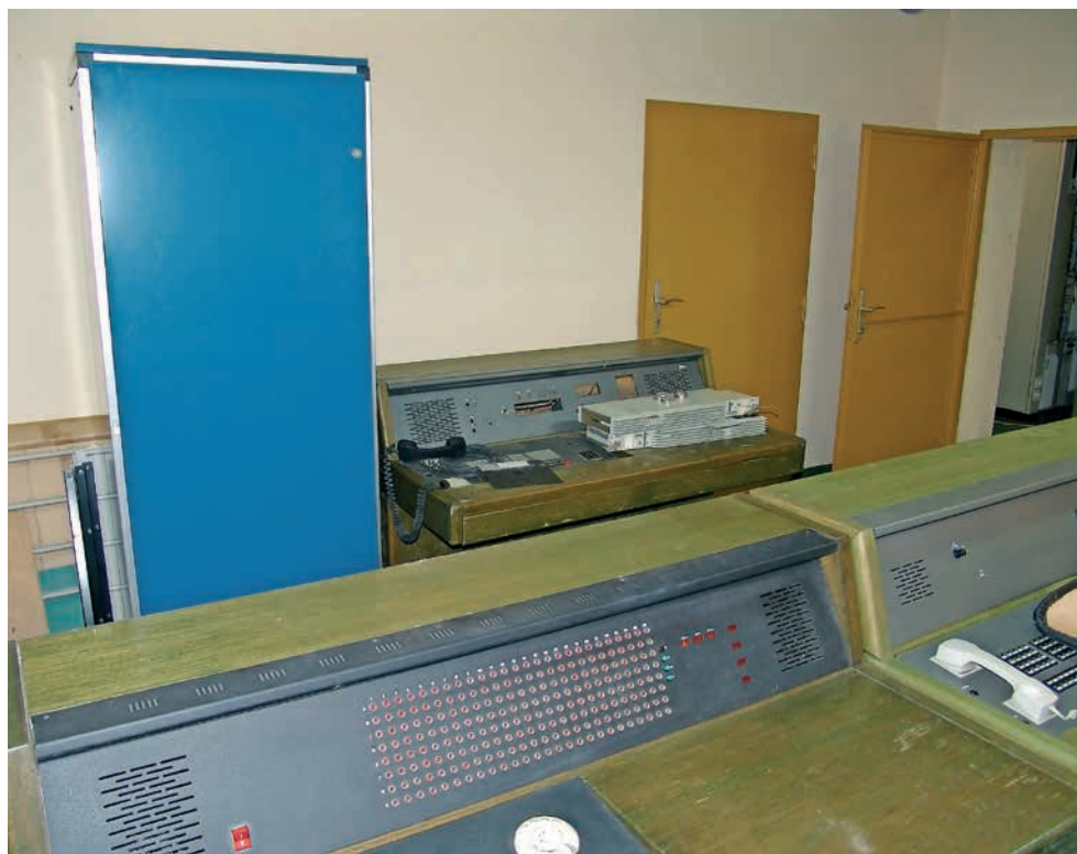
Stikalna miza za preklap do 200 prednostnih uporabnikov za vzpostavitev zvez na rezervnih in vojnih lokacijah (foto: Jernej Bizjak)
