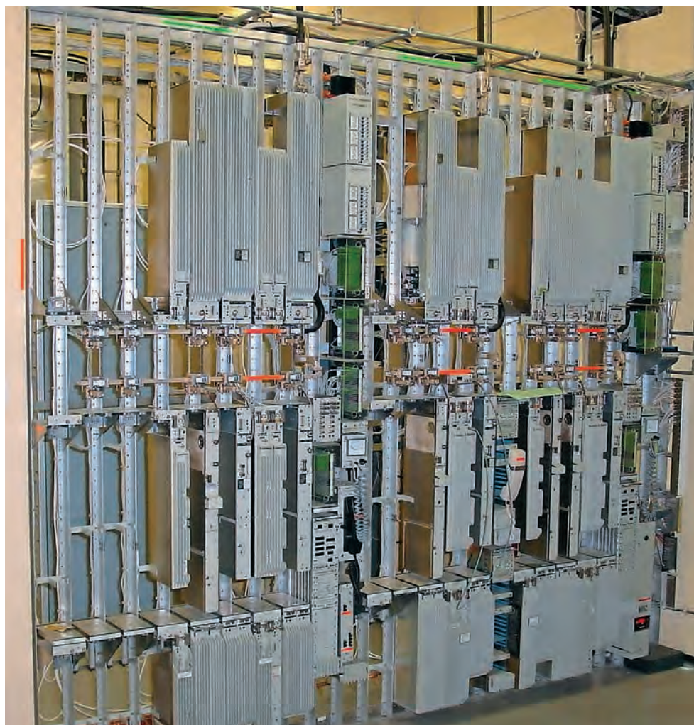
Digitalni radiorelejni sistem SEL/Siemens DRS 140/11200, lokacija Krim, smer Ljubljana (4 x 140 Mbit/s) in smer Nanos (2 x 140 Mbit/s) (foto: Darko Jelen)
