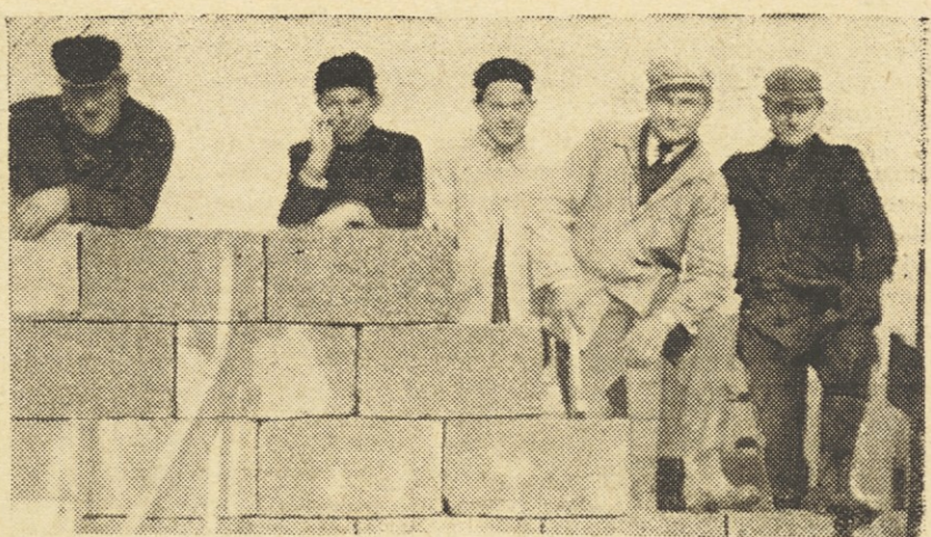
Mladina, pred tabo je lepša bodočnost! — Mladi zidarji na stavbišču
