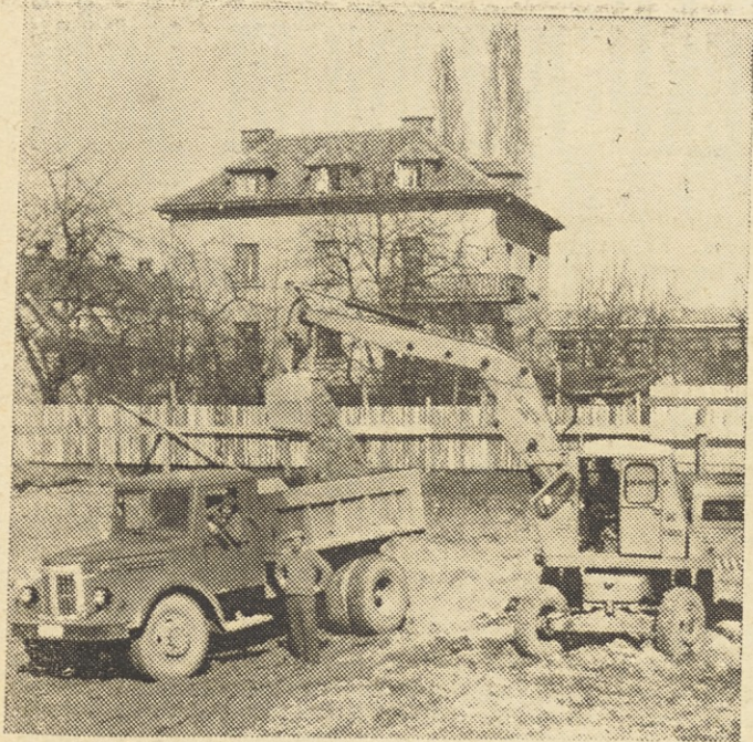
Novo gradbišče v Ljubljani — V bližini centrale podjetja je gradbeno vodstvo Ljubljana pričelo z gradnjo bloka za zdravstvo in tehnično varnost — Na sliki: začetek gradnje — izkopati je treba 3500 m 3 materiala
