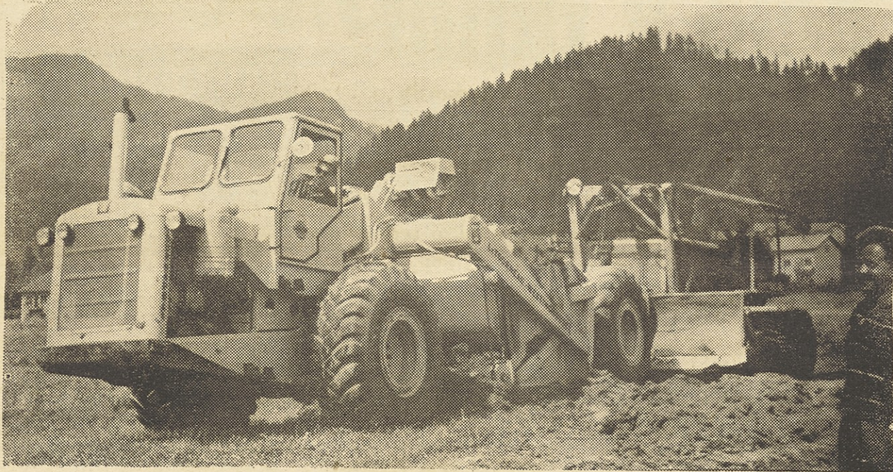
Motorni skreper na delu na Jesenicah s strojnikom Antonom Mišičem, ki pa se je že medtem prelevil v šoferja kamiona MAZ
