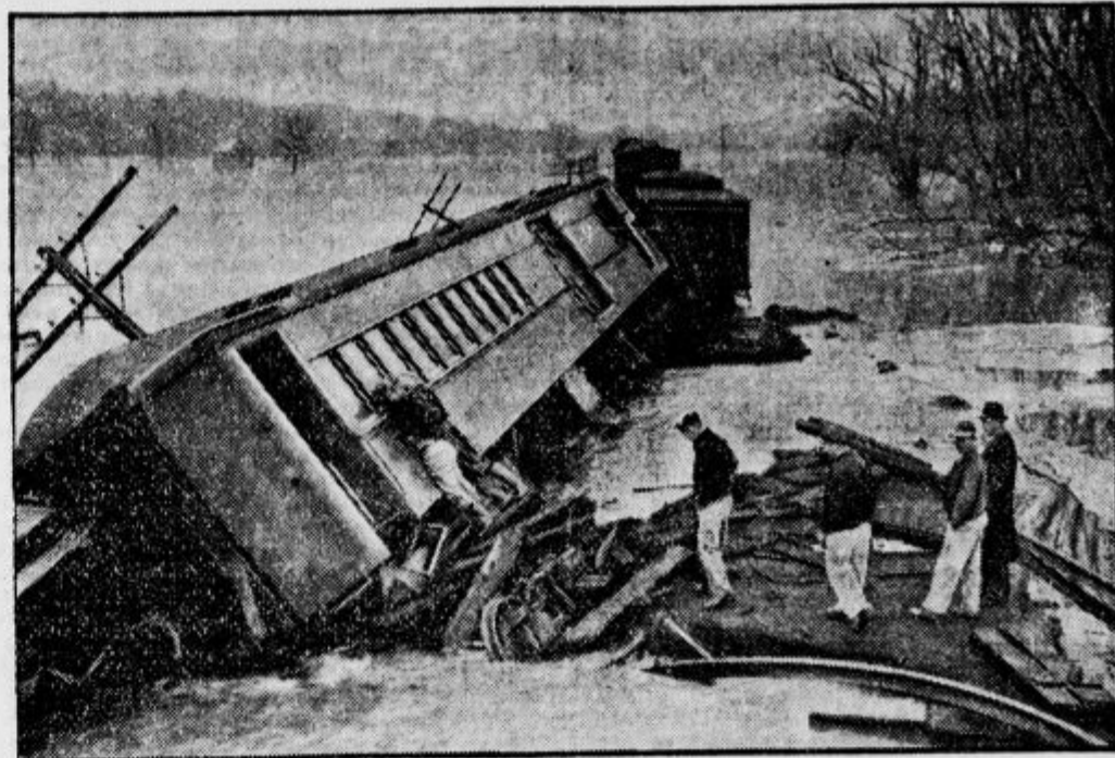
Pri New Jerseyu je zaradi povodnji skočil s tira vlak, ker je voda zalila nasipe in izpodkopala tračnice.
