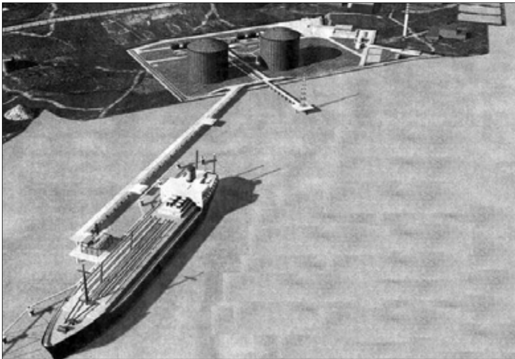
Načrtovani plinski terminal v Žavljah
