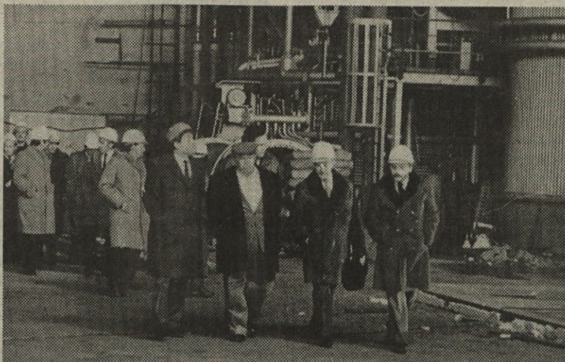
Stane Dolanc med ogledom gradbišča jeklarne 2 na Jesenicah
