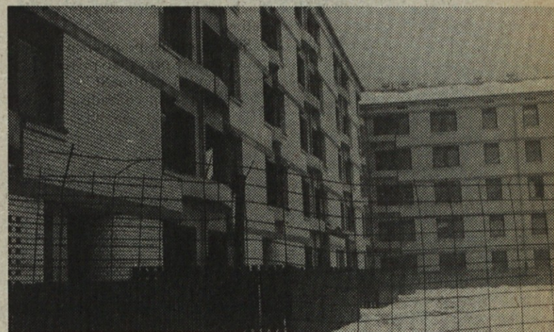
Edina stanovanja, ki jih gradijo v Celju dela naš tozd. Objekta A in B kareja 4 na Dolgem polju sta že vseljena
