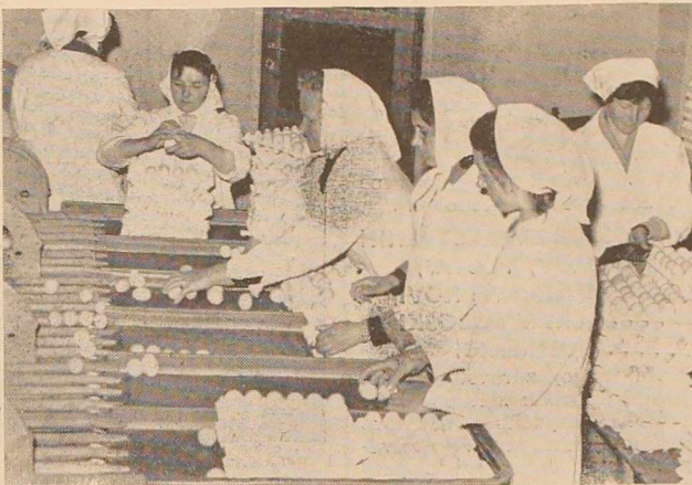
Sortiranje jajc je važno opravilo, ki ga zelo hitro in spretno opravlja sortirni stroj v KIK »Pomurka«, obrat Agromer-kur v Murski Soboti (foto Vučklič)
