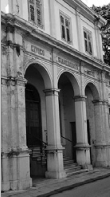
Stavba javnih kopeli v Ulici Cadorna
