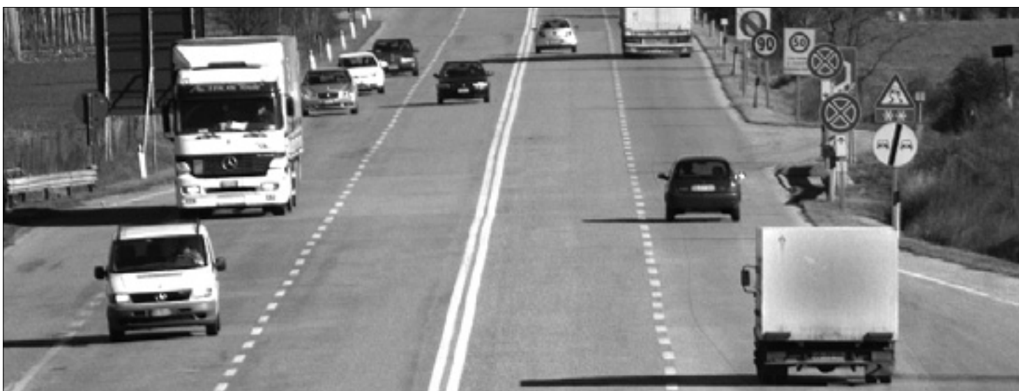
Odsek hitre ceste med Gorico in Vilešem, ki čaka na prekatégorizacijo
