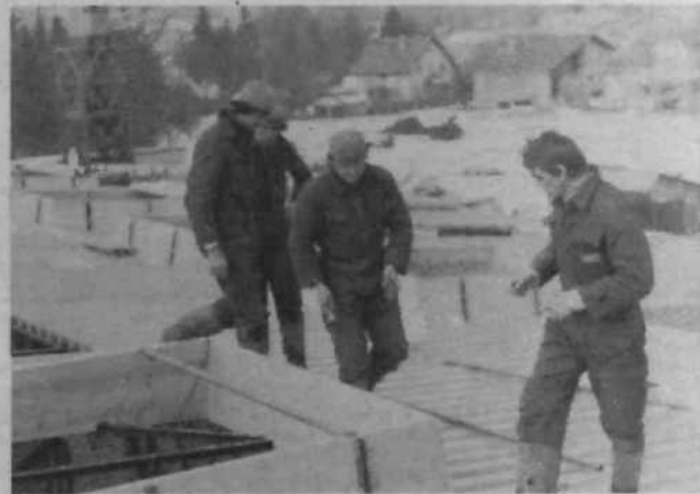
Delavci Termike veliko delajo tudi za Bežigradom. Pred kratkim so končali dela na športno rekreacijskem centru Ježica, zdaj pa delajo na novi osnovni šoli na Črnučah, od koder je naš posnetek.
