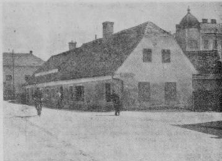
Tedni so šteti tudi tej hiši v Lackovi ulici, ki bo podrti zaradi pridručka na novi most
