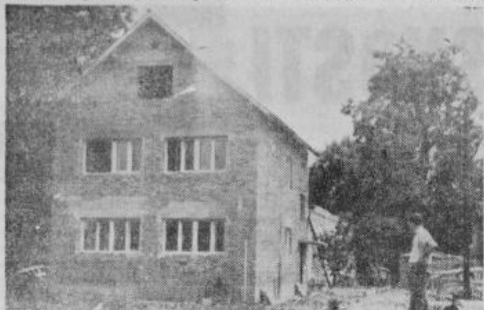
Zidarska dela na gospodarskem dvorišču KG Dravinjski vrh
