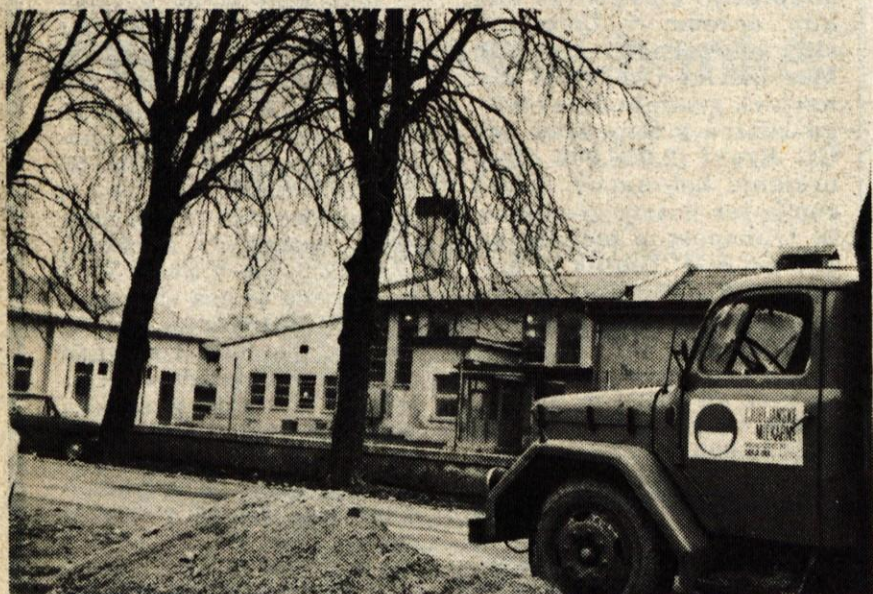
Del prenovljenega klavničnega obrata v Škofji Loki
