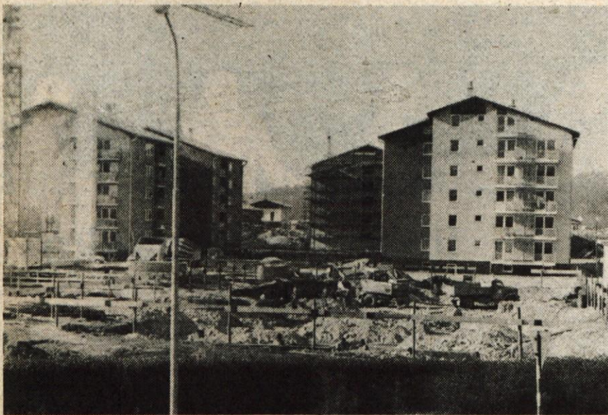
Gradbišče na Bakovniku ob Klavčičevi cesti, o katerem smo pisali nedavno. Zadnji od petih blokov je že v delu. Gradnja kljub neugodnemu vremenu lepo napreduje. Dela izvaja kamniški Graditelj. - a
