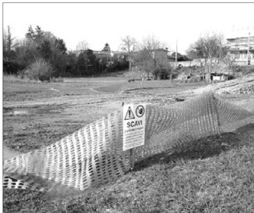
Južnega nasipa še niso zgradili
