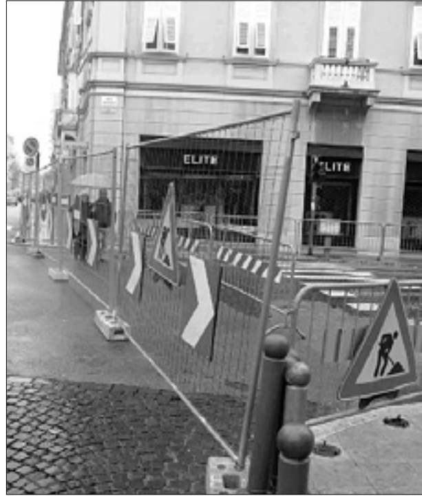
Zapora ulice Garibaldi
