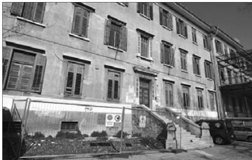
Opuščeno poslopje na Canestrinijevi ploščadi
