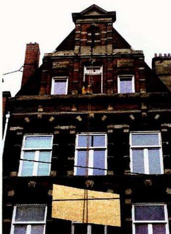
Dvigovanje večjih predmetov z zunanje strani stavbe
