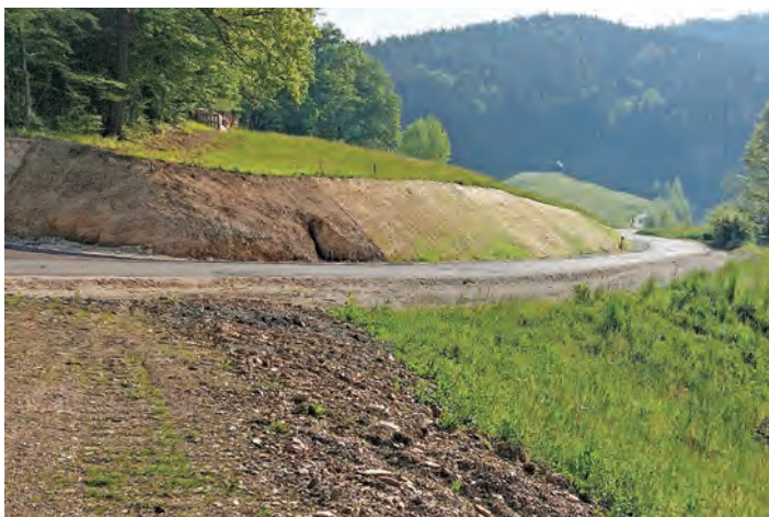
Gradnja ceste v območju OPPN Drtjiščica ob Gradiškem jezeru je zaključena.
