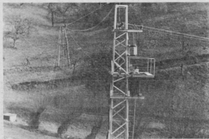
Trafo postaja in obnova omrežja v Halozah (foto z. kodrič)
