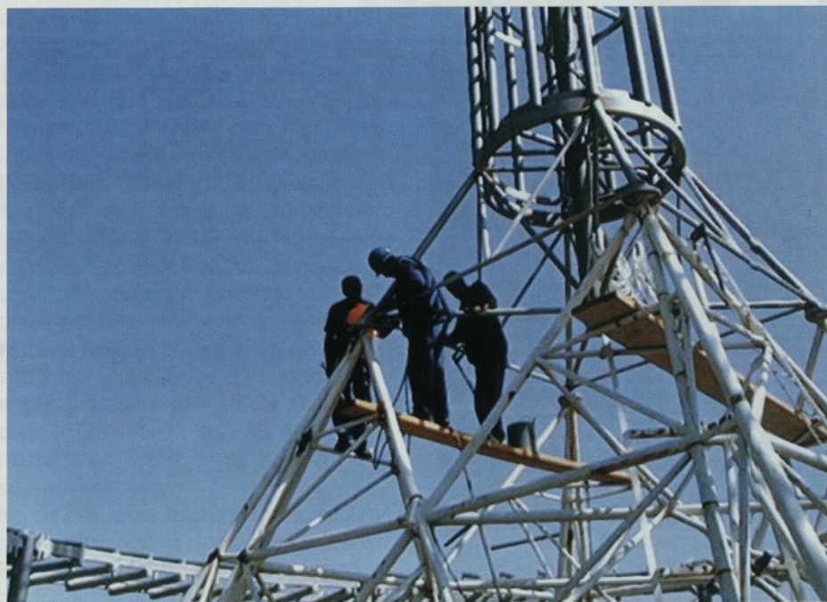
Slika 14 • Priključevanje novega na stari del stolpa
