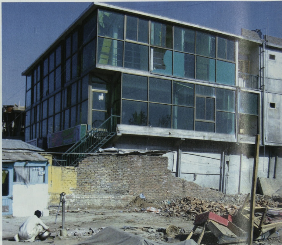
Slika 14 • Abotabad: zidana polnila so zmanjšala deformacije okvirne konstrukcije sosednje stavbe za toliko, da so na fasadi popokale le redke šipe
