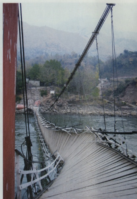
Slika 23 • Za prehod preko deroče reke Džhelum po visečem mostu, pri katerem se je med potresom na eni strani iztrgal kabel, je potrebno precej poguma
