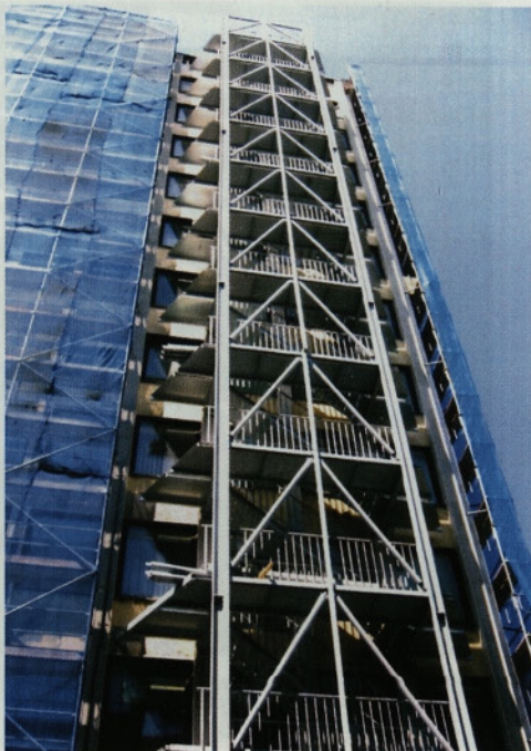
Slika 2 • Zmontirana jeklena konstrukcija stopnišča
