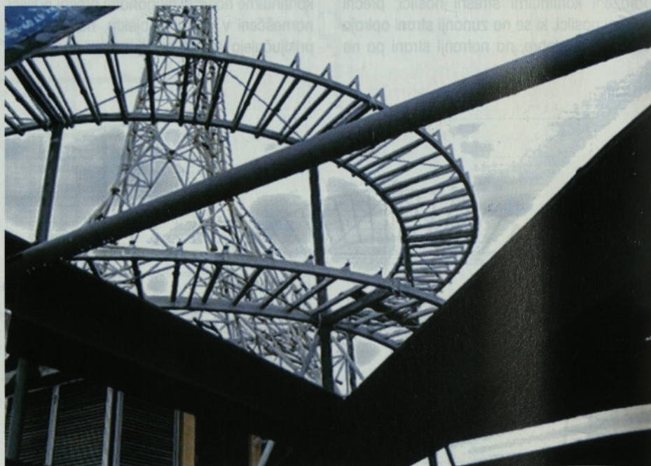
Slika 9 • Zmontiran stolp brez vertikalnih cevi za antene, v sredini še stari stolp
