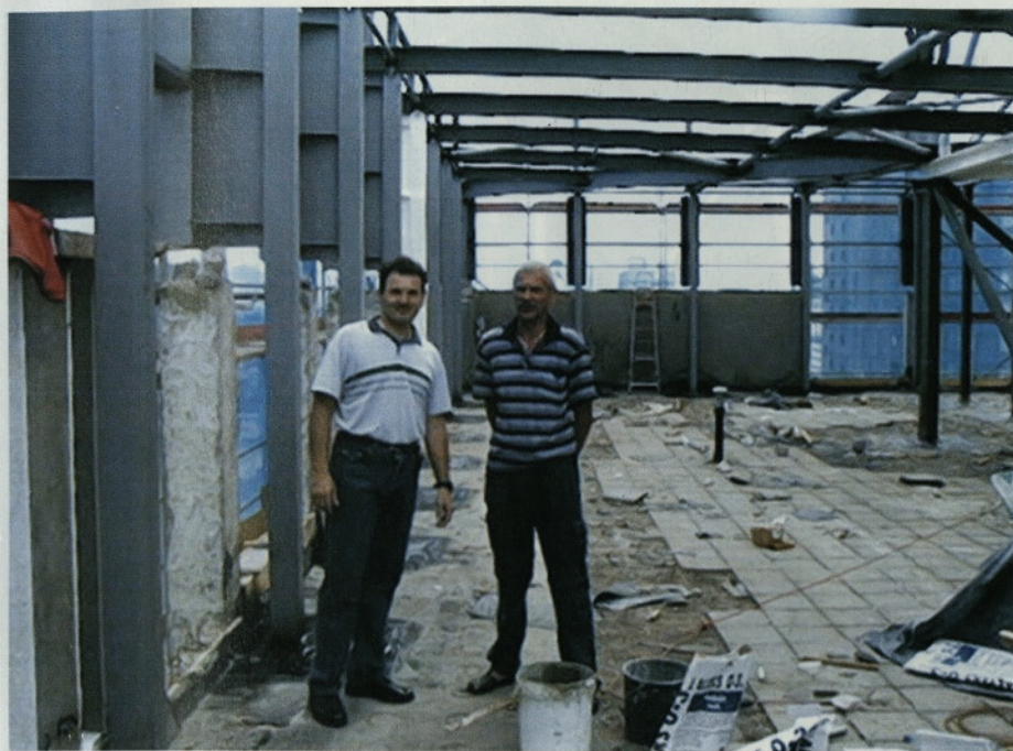
Slika 6 • Del prvotne terase z montirano jekleno konstrukcijo nove etaže
