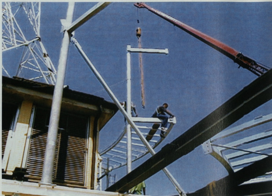
Slika 8 • Montaža stebrov in spodnjega kolobarja
