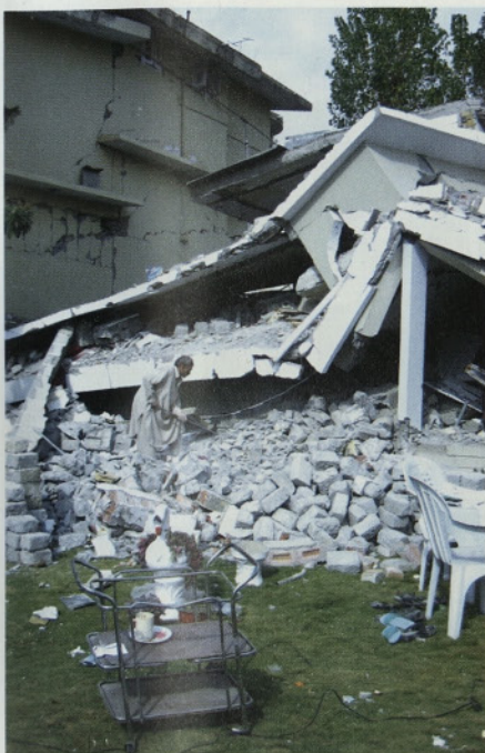
Slika 9 • Muzafarabad: zelo slabo so se obnesle hiše, sezidane iz betonskih blokov. Betonski zidaki bodo še uporabni: ali bo nova hiša sezidana kaj bolje?
