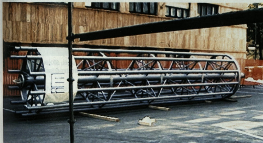
Slika 11 • Košasti del novega stolpa, pripravljen za montažo
