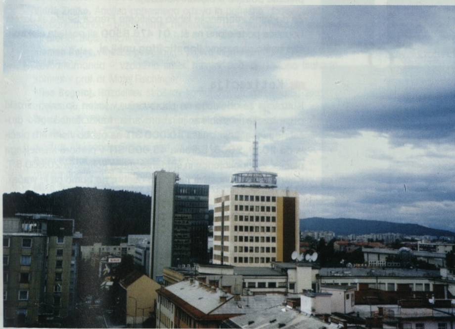
Slika 16 • Pogled na prenovljeno zgradbo s požarnim stopniščem, novo etažo in zunanjim ter notranjim antenskim stolpom
