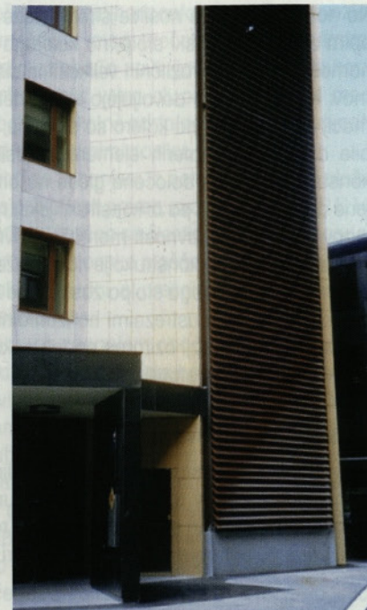
Slika 3 • Izgotovljeno požarno stopnišče, čelna fasadna stena z aluminijastimi žaluzijami in požarno odporni bočni steni iz Alucobond sendvičev
