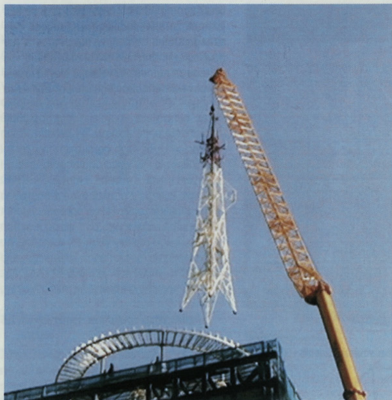
Slika 12 • Demontaža starega dela stolpa
