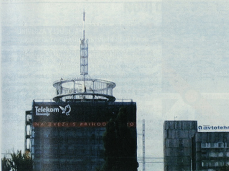
Slika 15 • Pred zaključkom montaže
