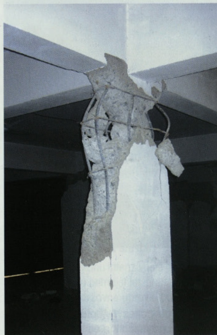
Slika 15 • Abotabad: plastični členek v neustrezno armiranen stebri
