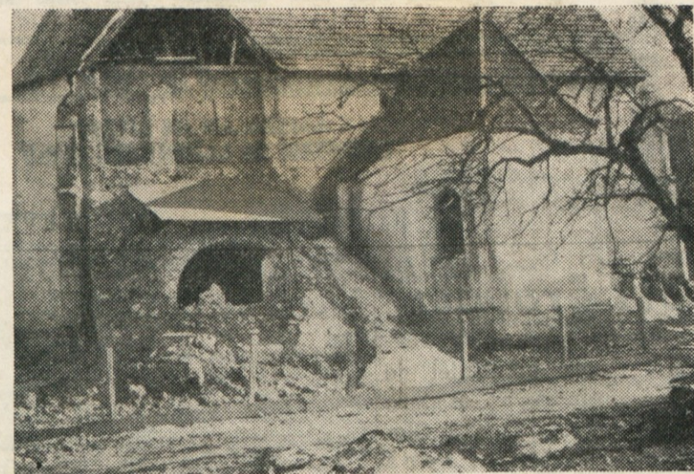
Cerkev v Večni vasi po odstranitvi ruševin stolpa. Čisto na desni strani tik ob zidu trije zvonovi iz porušenega stolpa čakajo na novi stolp.
