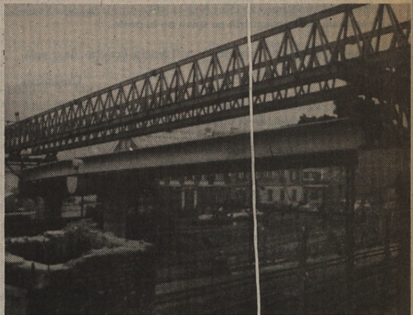
Polaganje nosilcev za nadvoz v Mariboru. Vodja zahtevne montaže je Stanko Eder.
