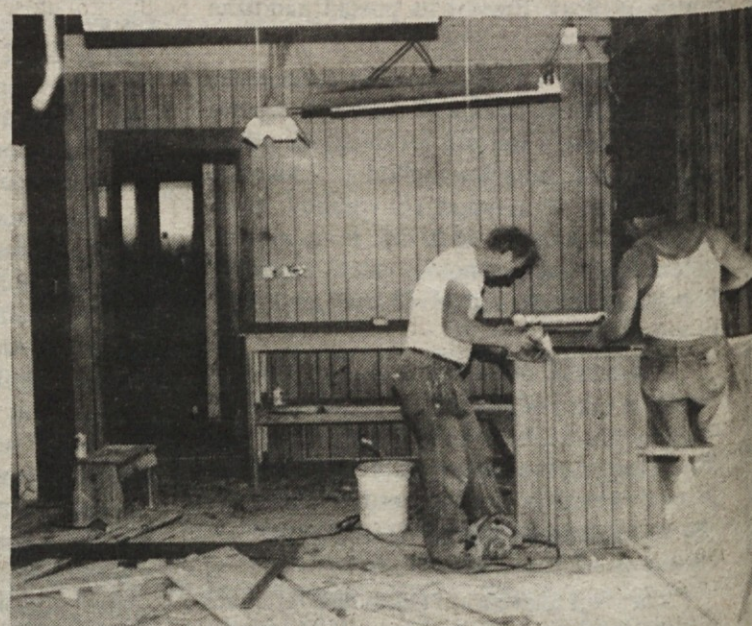
Kot vidite, obnova pisarniških prostorov je morala biti res temeljita. Na sliki sta John Kozina in Valentine Kavčič.
