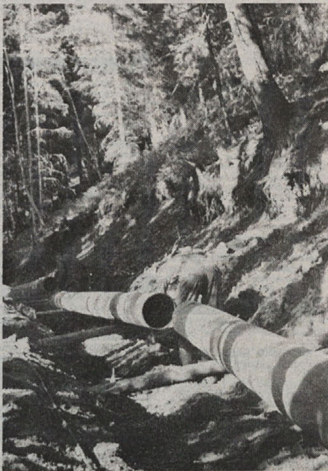
Gradnja cevodov, za Francovo elektrarno je bila zelo naporna. Potrebno je bilo kar 400 metrov cevi.
