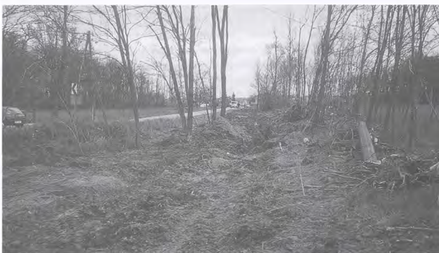
Izgradnja transportnega vodovoda Gančani-črpališče Hraščica
