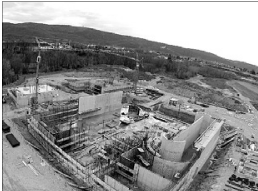
Gradbišče čistilne naprave v Vrtojbi
