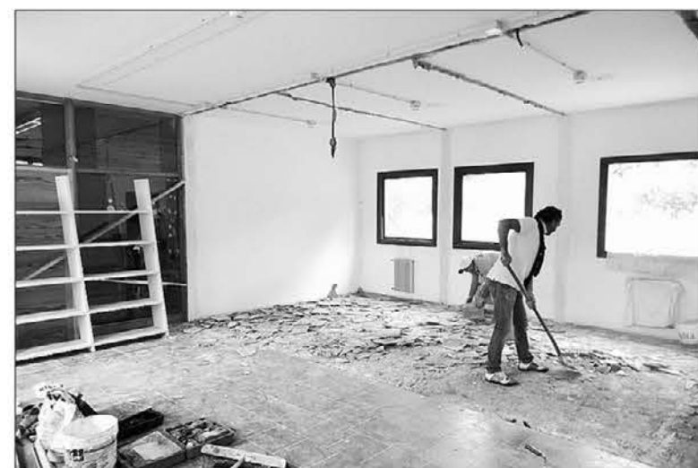
Lavori in corso nella nuova aula della scuola per l'infanzia
