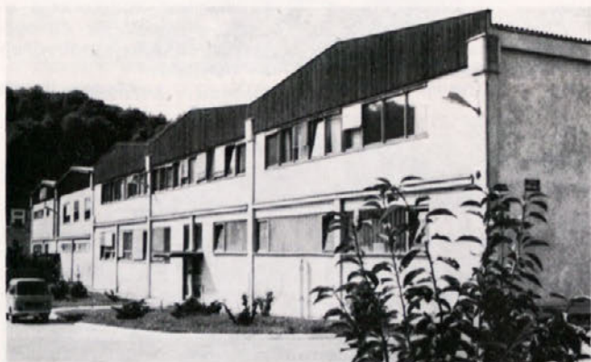
Proizvodni objekt TEŠ Senovo
