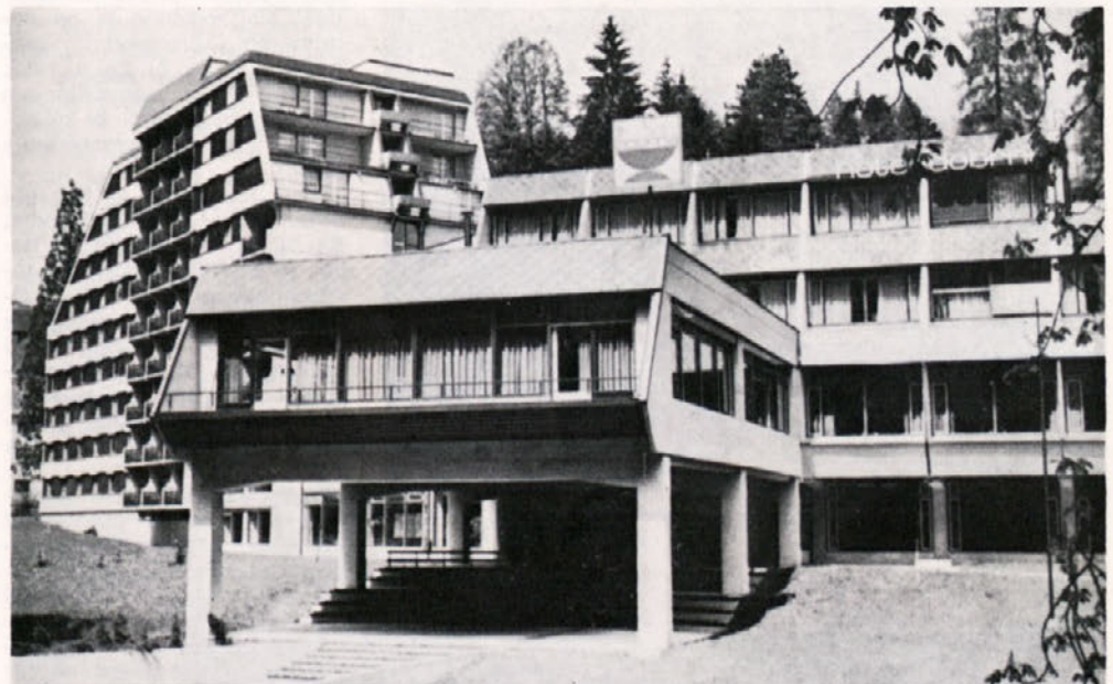
Hotel Dobrna — izvajalec del Gradbena operativa Celje
