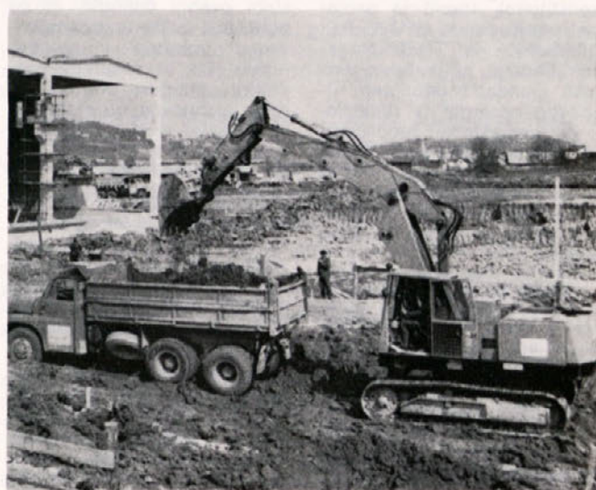
Gradbena mehanizacija za zemeljska dela
