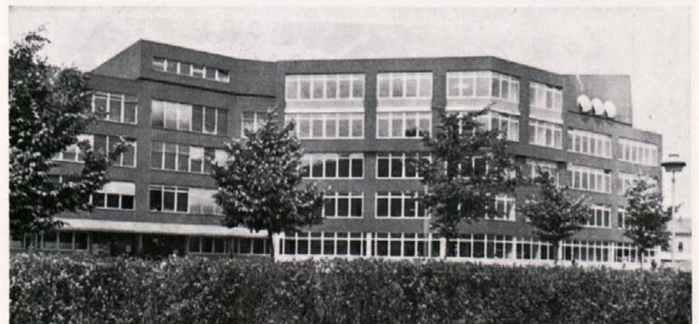
Tehniška šola Celje — izvajalec del Gradbena operativa Celje
