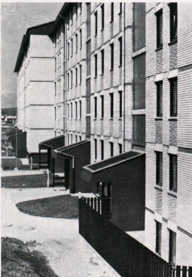
Blok prilagodljivih stanovanj v soseski Hudinja
