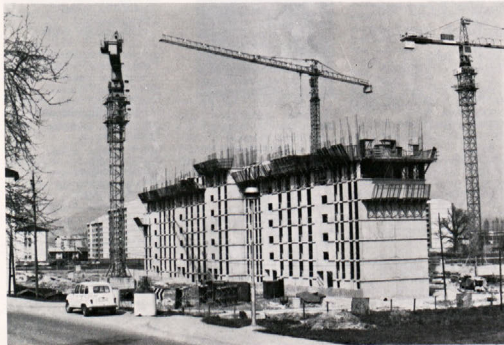
Gradbišče stanovanjske soseske Hudinja — izvajalec del GO
