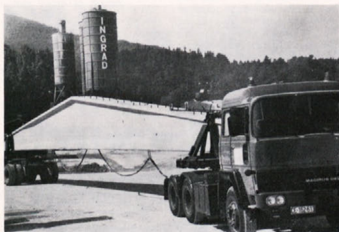
Spredej odvoz nosilca, zadaj obrat betonarne
