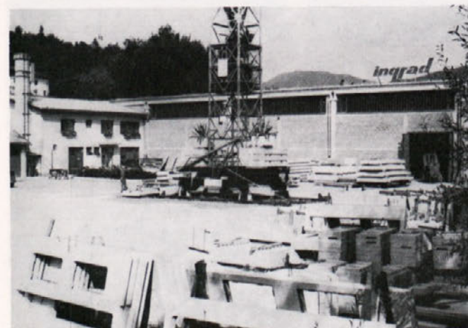
Obrat za izdelavo montažnih trafo postaj
