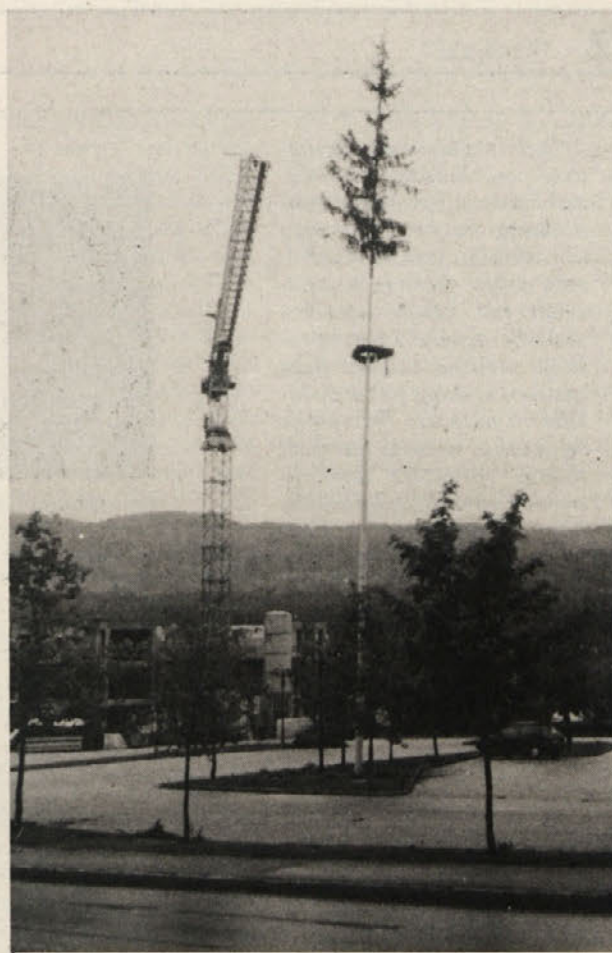
Pravo sožitje ob gradbišču: prvomajski mlaj in gradbeno dvigalo (žerjav), simbola dela in delavskega praznika
