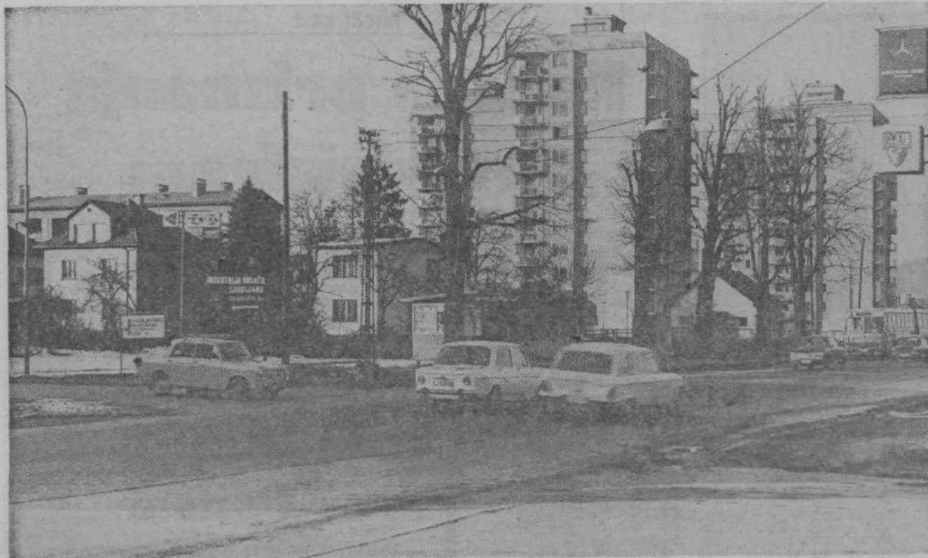
Na križišču Titove ceste in Tolstojevе ulice bo zaradi novega semaforja manj zastojev
