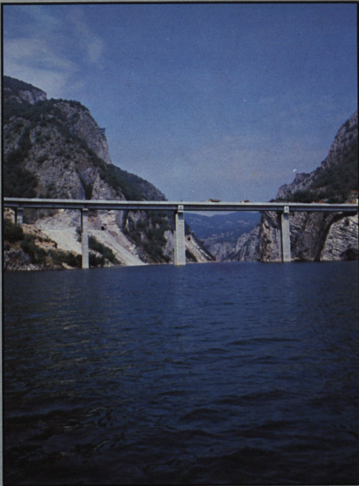
Eden od 27 zgrajenih mostov in viaduktov v dolini Drine pri Višegradu. Gradis dobro ime razširja tudi v druge jugoslovanske republike.
