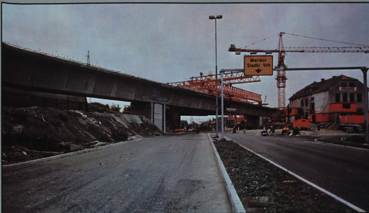
Šentiljski viadukt, gre za dva vzporedna in medseboj ločena objekta, bo dolg 160 metrov, zgrajen pa bo maja prihodnje leto. Gre za konzolno gradnjo s pomočjo montažne konstrukcije.
