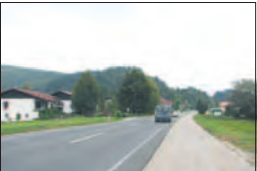
Letos bodo kolesarske steze in pločnike gradili od Lukovice in skoraj do osnovne šole.
