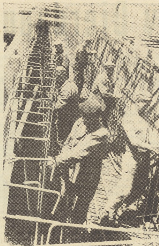
Na levi Pecikova železokrivska brigada pri gradnji mostu čez Dravo — Na desni pa eden izmed številnih graditeljev Franc Marko
