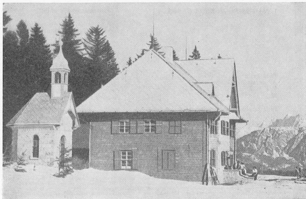
Nekdanji planinski dom na Kofcah, zgrajen l. 1927, požgan med vojno. V ozadju Kamniške Alpe
