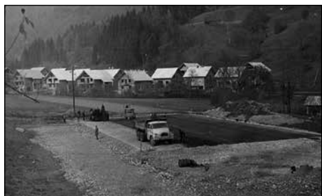
Gradnja roketnega igrišča v Dašnici.
