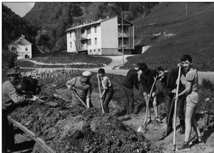
Na gradbišču avtobusne postaje.
