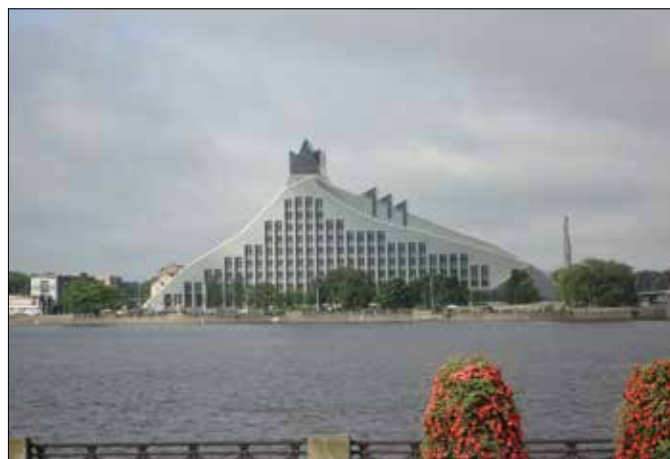
Slika 1: Nova stavba latvijske nacionalne knjižnice – zunanost
