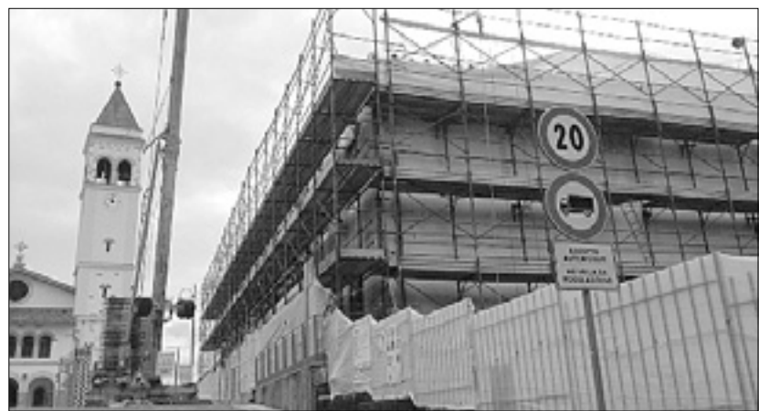
Gradbišče Sedejevega doma in računalniški prikaz obnovljene stavbe
