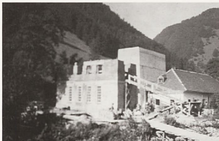
Izgradnja nove elektrarne.
