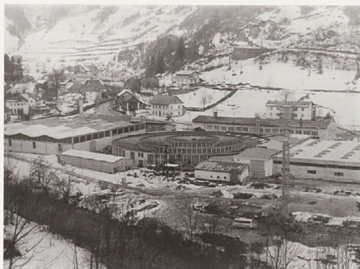
Domel pred izgradnjo skladišča nevarnih snovi.
