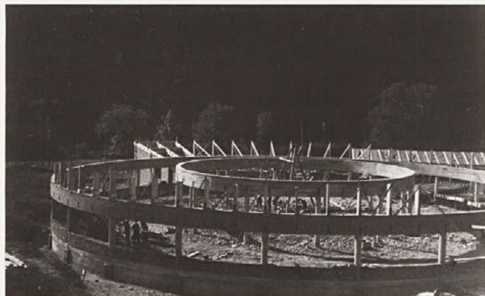
Gradnja okrogle hale, ki je bila zgrajena leta 1958.
